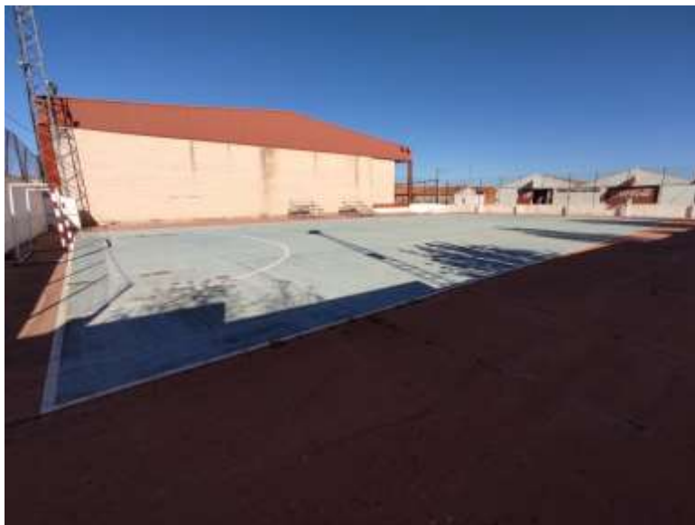
Vista general de la instalación
