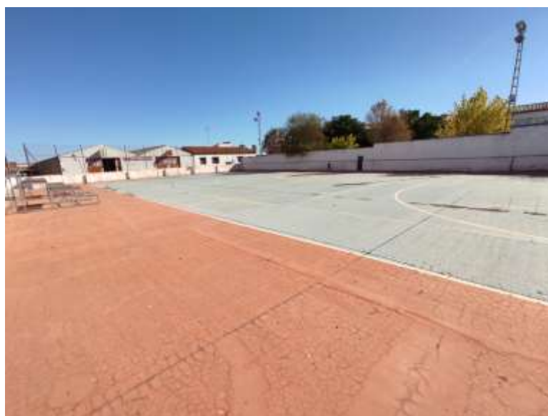
Puerta central de la instalación a la que habría que dotarle de accesibilidad
